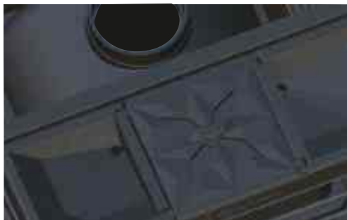
Поворотные заслонки в закрытом положении
